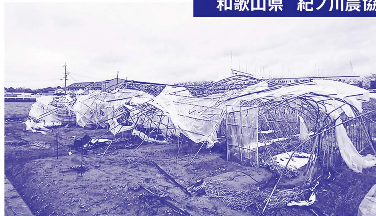
多くの農家でビニールハウスがやぶれ、ハウスの倒壊や、パイプ自体も曲がっている被害がでています。
