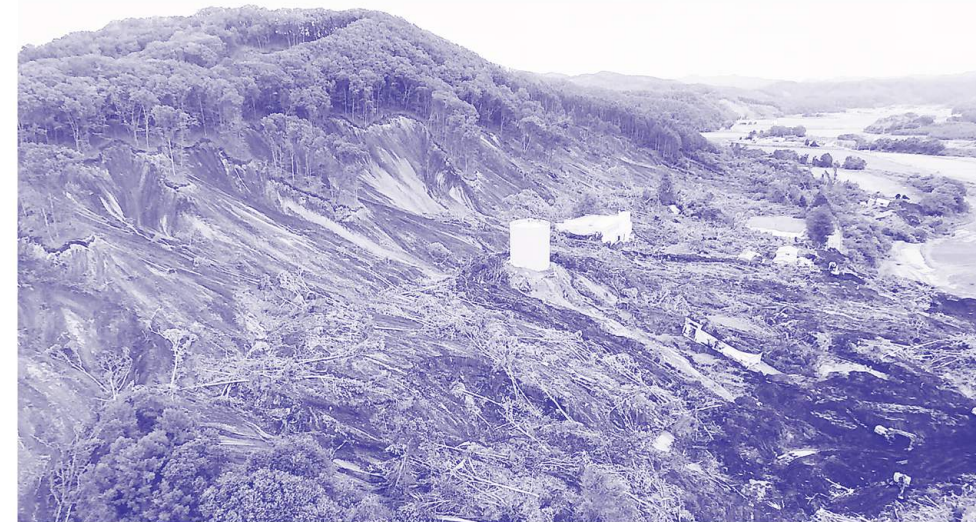
北海道胆振東部地震 土砂が押し寄せた 浄水場
