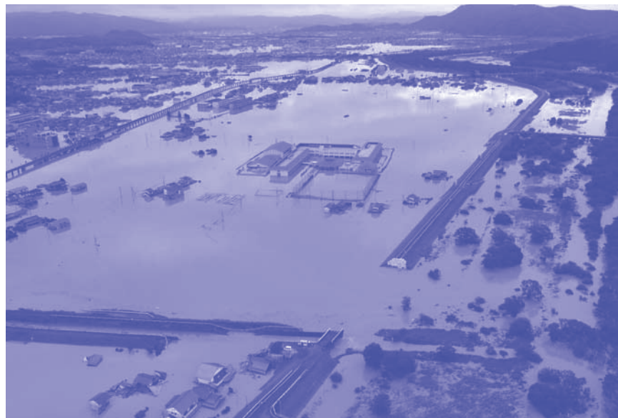
写真：時事 大雨により決壊した小田川の堤防（中央右下）＝7月8日午前、岡山県倉敷市上空（時事通信社ヘリコプターより）
